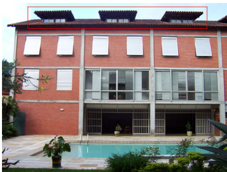
Fig. 14: Casa do Alto (também chamada pelos monges de Cella São Gerardo), fachada posterior. Em vermelho, o acréscimo realizado. (Foto da autora, novembro 2003).
