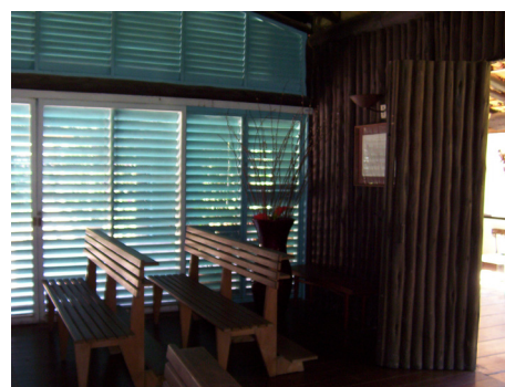
Fig. 261 e 262: Venezianas de madeira da Capela Santa Maria na Casa Accioly em Petrópolis. (Fotos da autora, abril 2003).
