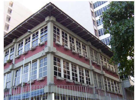
Fig. 32: Escola Dr. Cícero Penna em Copacabana, Rio de Janeiro. Observar as esquadrias de madeira desta escola e da Escola Roma [Figura 4 deste trabalho]. (Foto da autora, fevereiro de 2004).
