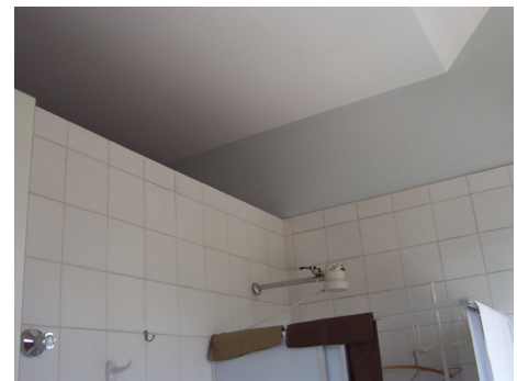
Fig. 212: Detalhe dos banheiros das celas da Enfermaria. (Foto da autora, novembro 2003).
