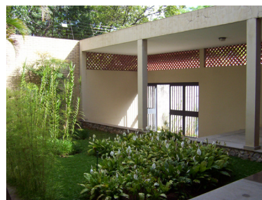
Fig. 100 e 101: Fachada Nordeste – volumes alinhados com revestimento em lito-cerâmica. Detalhe da marquise em concreto no átrio da Igreja dos Fiéis, ocultada pelo fechamento imposto à fachada. (Fotos da autora, novembro 2003).
