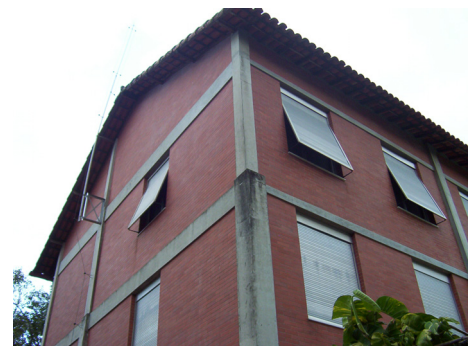
Fig. 114: Casa do Alto (Rio de Janeiro, 1984). Observar o pilar diminuindo de seção. (Foto da autora, outubro de 2003).
