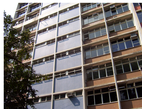
Fig. 23: Fachada posterior (Edifício Diogo de Brito), na Ladeira de São Bento. Foto da autora, outubro 2003)
