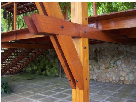
Fig. 17: Detalhe dos pilares frontais da Casa Adolpho Bloch. Ao fundo, o muro de embasamento. (Foto da autora, fevereiro de 2004).
