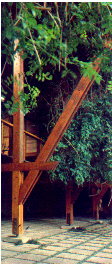
Fig. 309: Detalhe dos pilares em madeira da Casa Adolpho Bloch (Teresópolis). (Fonte: Revista Manchete – Especial Trinta Anos – Bloch Editores).
