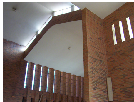
Fig. 255: A diferença de altura entre as coberturas das Igrejas e do altar, proporciona a entrada de luz. (Foto da autora, maio 2003).
