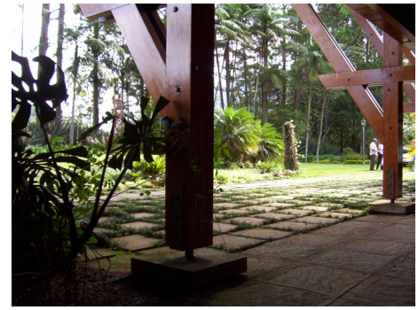
Fig. 31: Detalhe da base do pilar na Casa Adolpho Bloch em Teresópolis. (Foto da autora, fevereiro de 2004).
