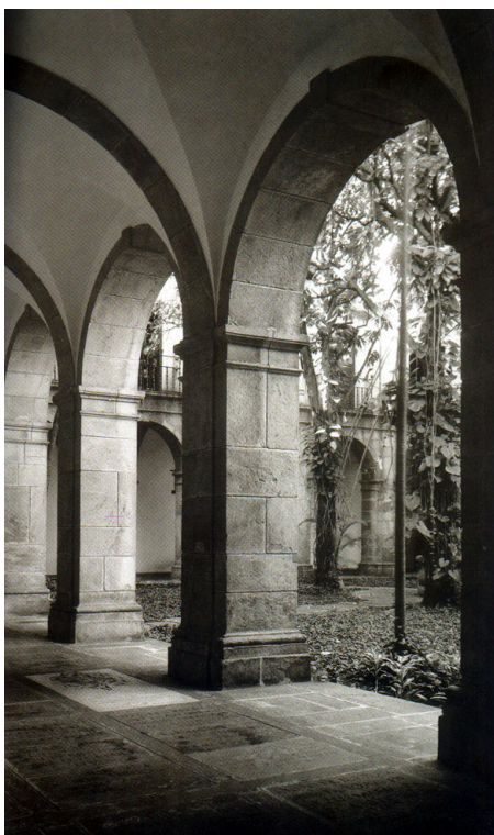
Fig. 299: Claustro do Mosteiro de São Bento do Rio de Janeiro. (Fonte: ROCHA, 1991).
