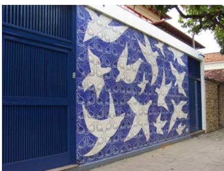
Fig. 350: Fachada principal do Educandário Dom Silvério em Cataguases. (Foto da autora, outubro 2003).
