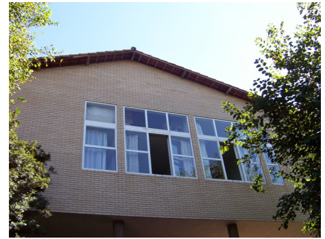
Fig. 133: Fachada lateral, Bloco 2 (Hospedaria), com revestimento em lito-cerâmica que acompanha o que foi determinado para a fachada frontal. (Foto da autora, maio de 2003).
