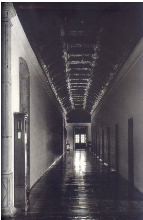
Fig. 239: Corredor do pavimento superior do Mosteiro de São Bento do Rio de Janeiro, do lado da Ilha das Cobras. (Fonte: ROCHA, 1991).
